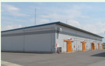
新倉庫の外観。円高を利用して、原材料を多めに輸入、ストックする企業も増えている
